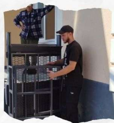
MONTAŻ WINDY DLA NIEPEŁNOSPRAWNYCH W SZPITALU W ŻYTOMIERZU
